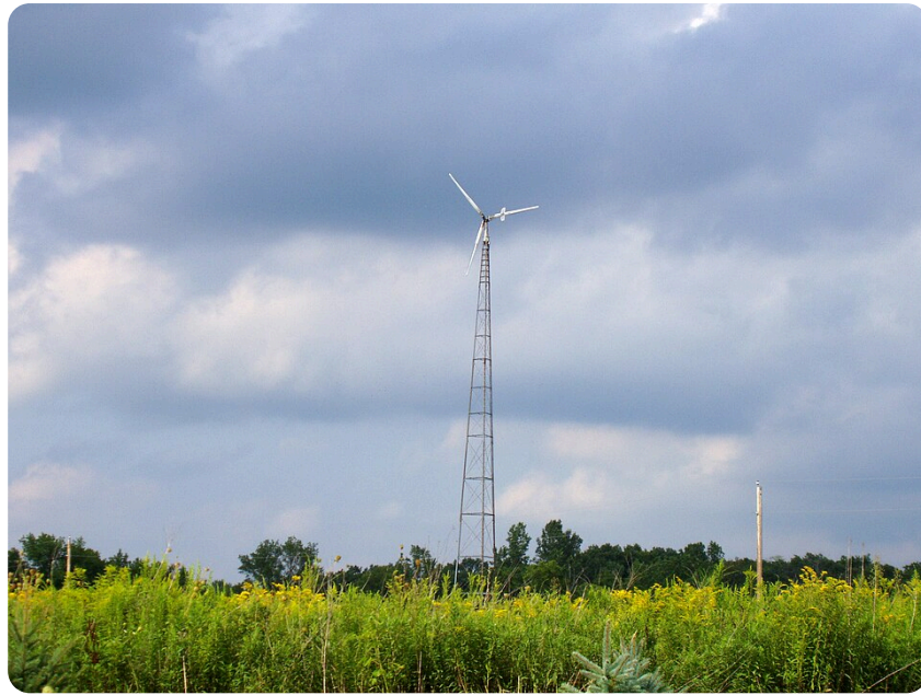
Kleines Windrad im Garten (Foto: CC BY 2.0, via Wikimedia Commons) — Standort frei und hoch, Mast abgespannt
