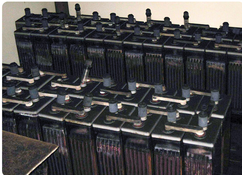
Blei-Akku-Bank: günstig und bewährt — aber nur 50 % der Kapazität nutzbar (Foto: Pseudoznanstvenik, CC BY-SA 3.0, via Wikimedia Commons)
