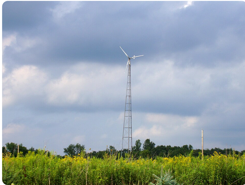
Pequeño aerogenerador en el jardín (foto: CC BY 2.0, vía Wikimedia Commons) — emplazamiento despejado y alto, mástil con tirantes
